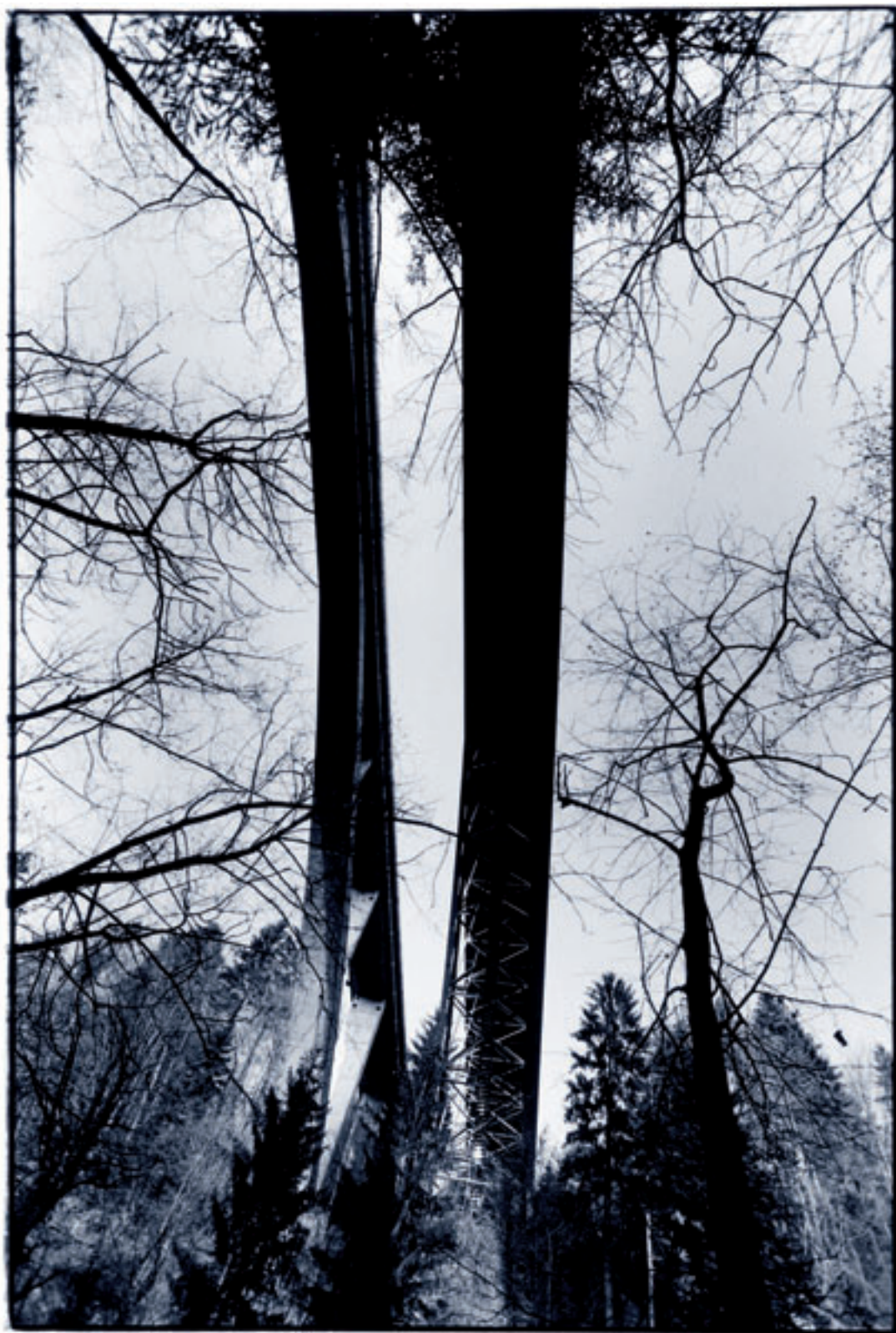
Ponts « Schwarzwasserbrücken » pour route et train
