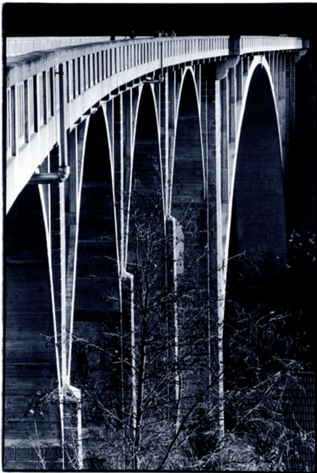
Pont « Halenbrücke » entre Berne et Kirchlindach
