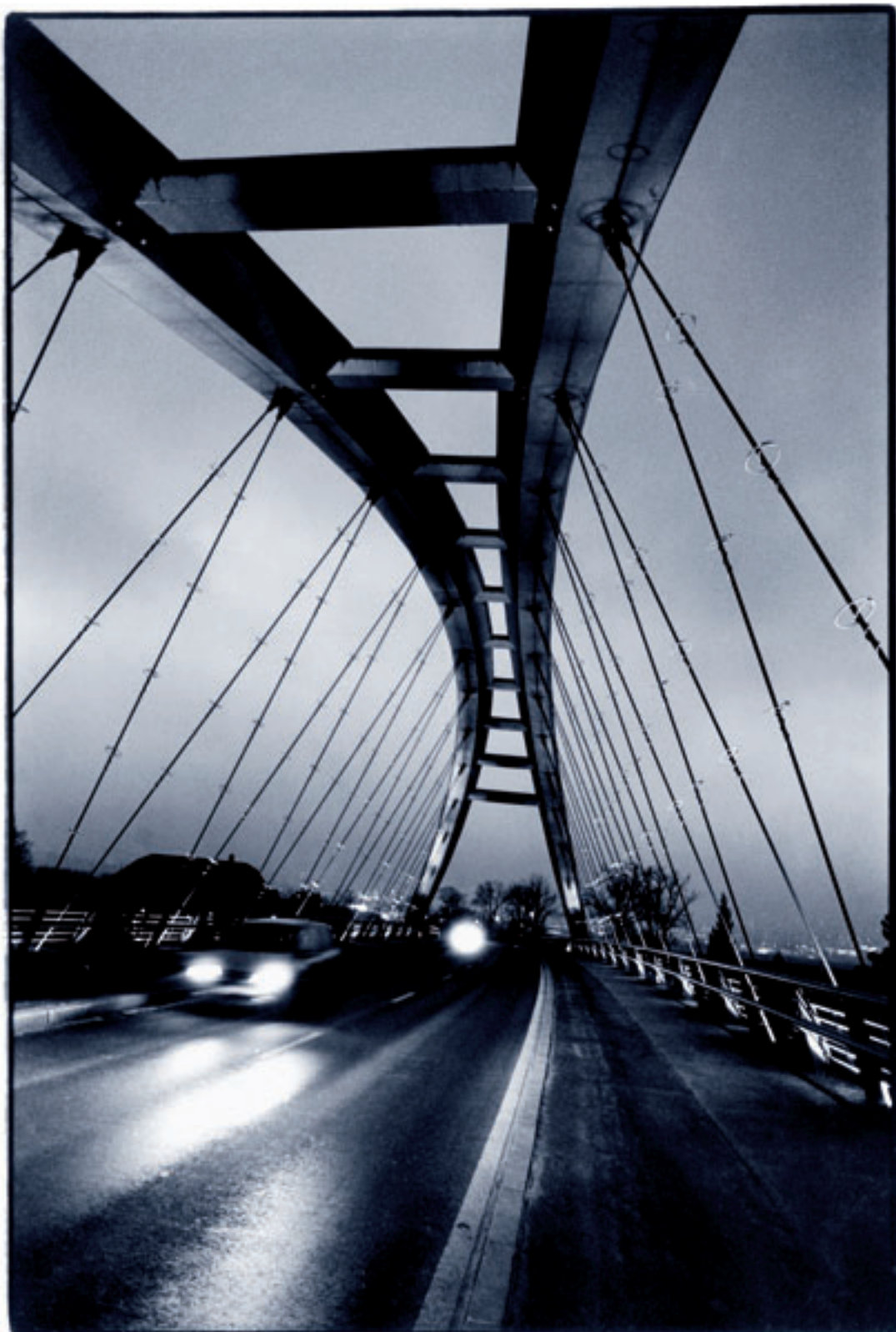
Pont de l'Aare entre Grenchen et Arch
