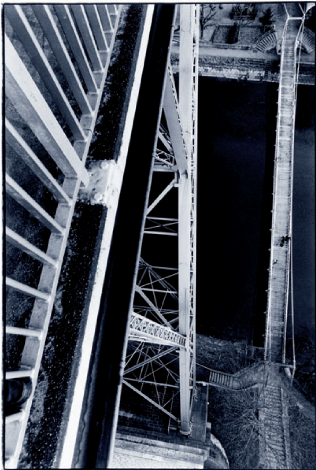
Passerella d'Altenberg sotto il ponte del Kornhaus a Berna
