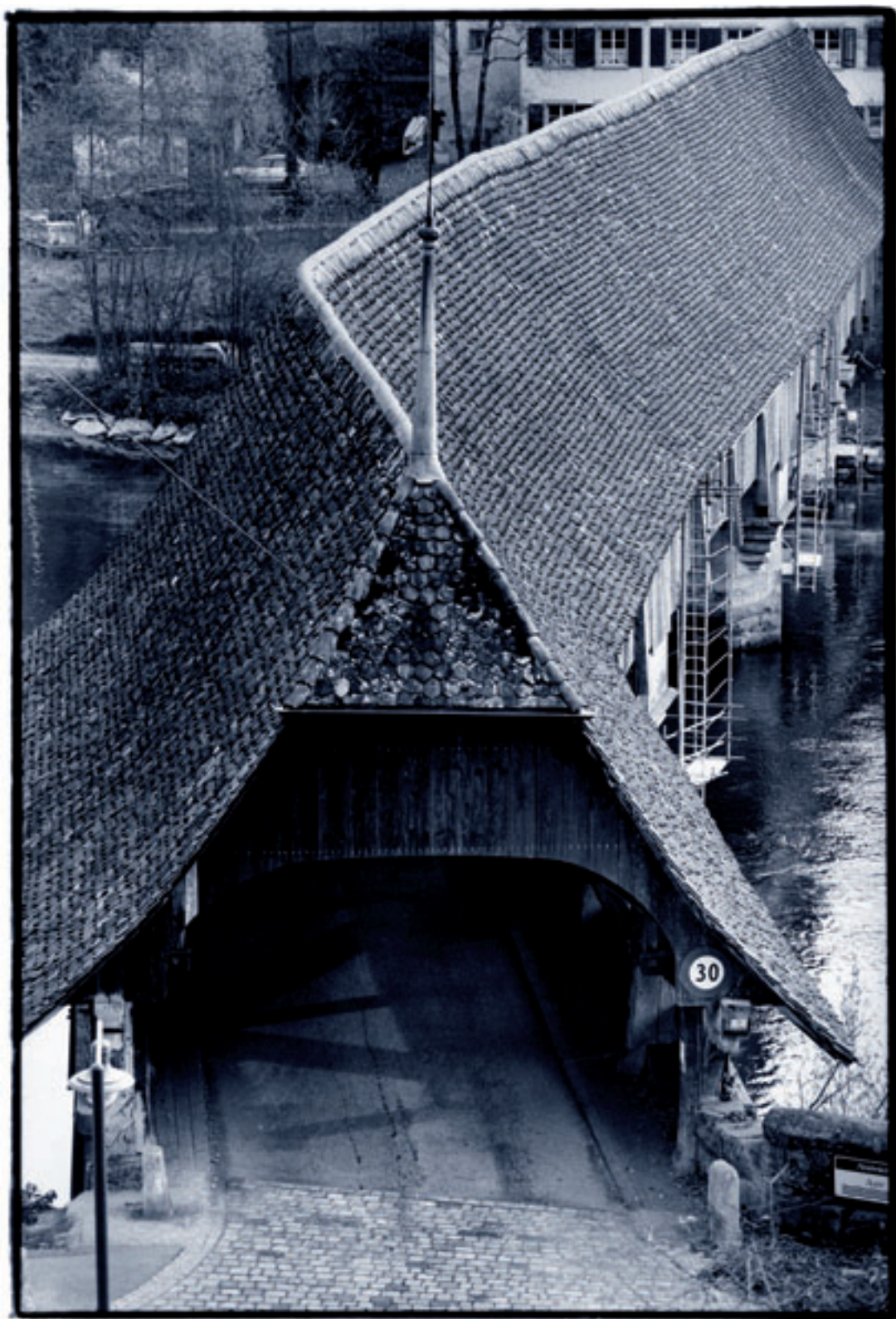
Ponte «Neubrücke» tra Berna e Stuckishaus
