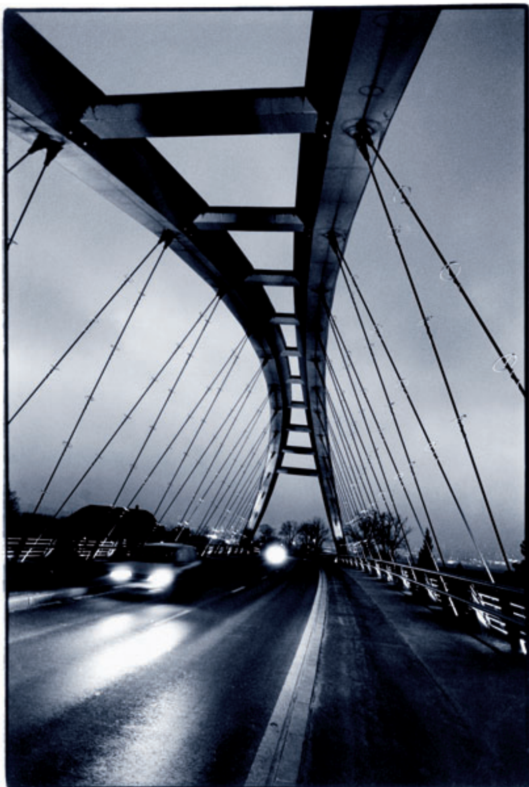
Ponte «Aarebrücke» tra Grenchen e Arch
