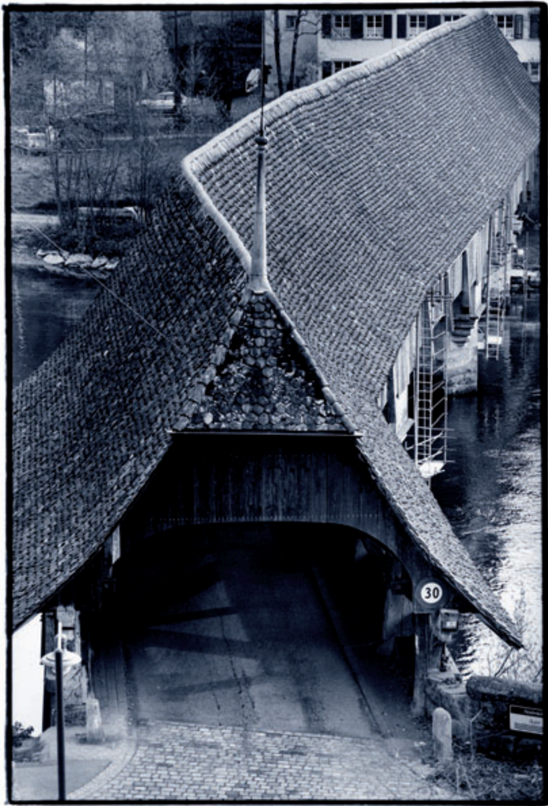
Neubrücke zwischen Bern und Stuckishaus
